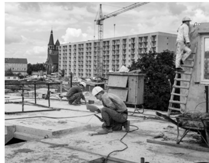
Wolfstraße 1-10 (größtes Haus von Nordhausen mit 160 Wohnungseinheiten)
