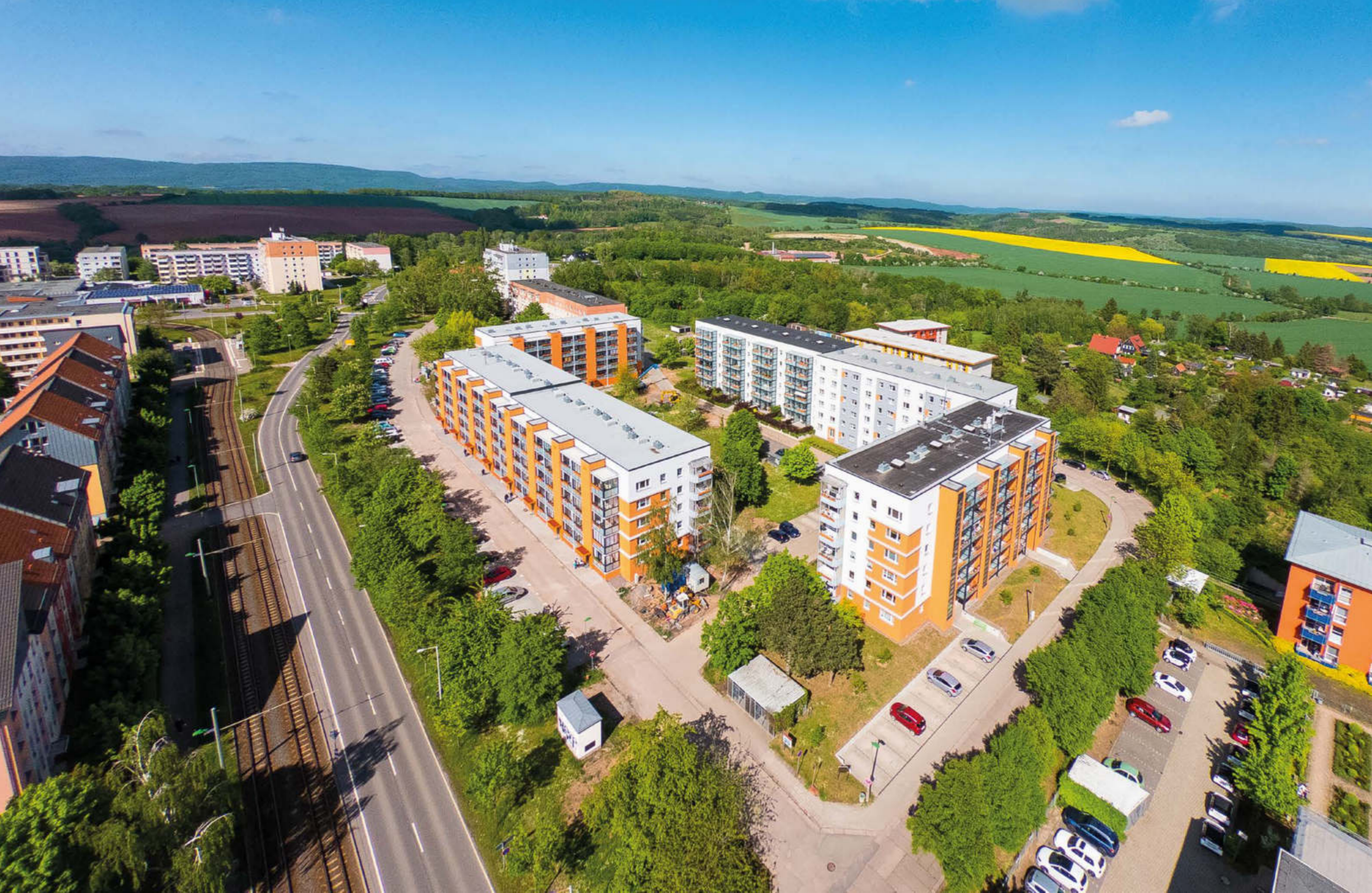
Fertigstellung des Quartiersmanagementkonzeptes „SENIORENWOHNEN PLUS“ in Nordhausen Nord mit Abschlussarbeiten des Wohnumfeldes, Juni 2021
